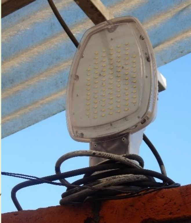
Figura 3 Lámpara LED operando a 120 VCD ( Cordova-Fajardo & Tututi Hernández ).
